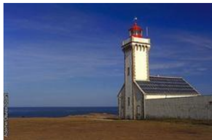
Le phare des Poulains de Belle Ile en Mer équipé en photovoltaïque
